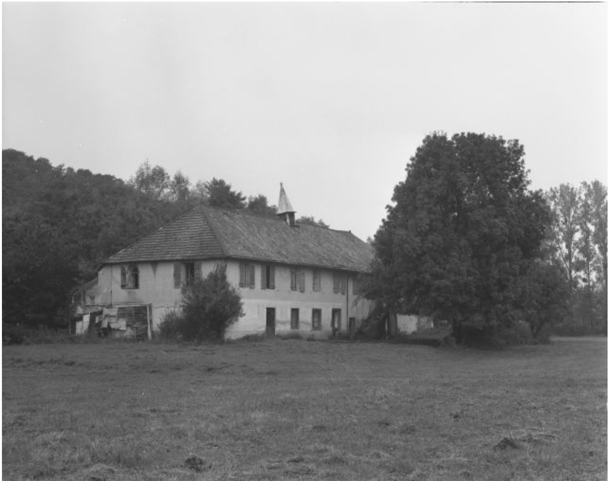
Le presbytère depuis le sud-est.
