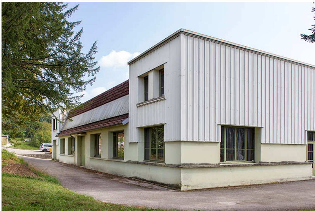
Atelier construction : façade postérieure.
