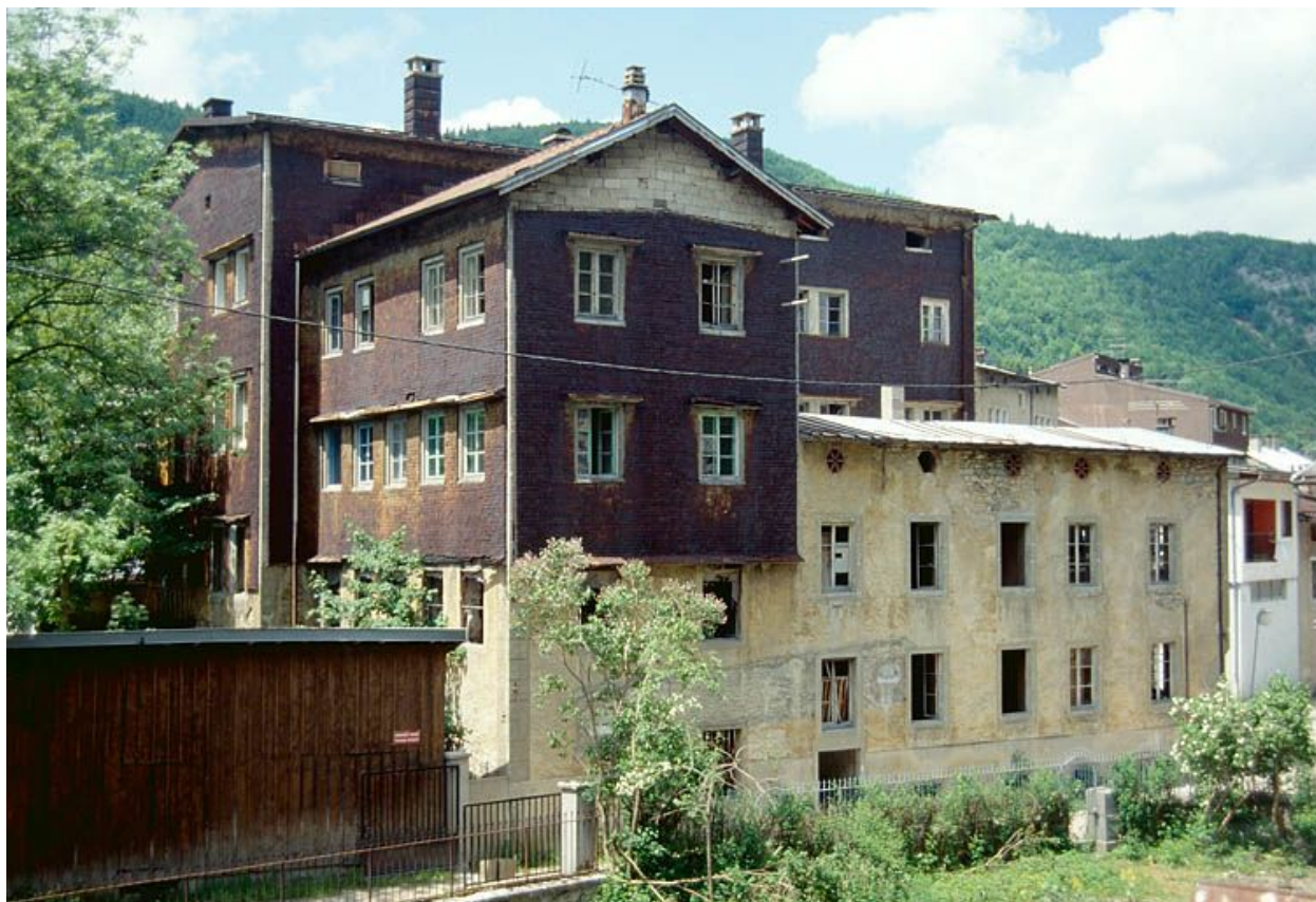
Bâtiment 6-8 rue Victor Poupin : façade postérieure.
