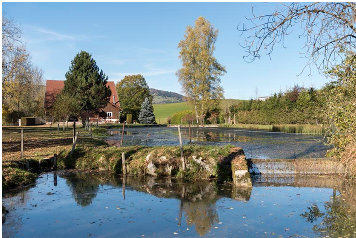
Le bassin de retenue.
