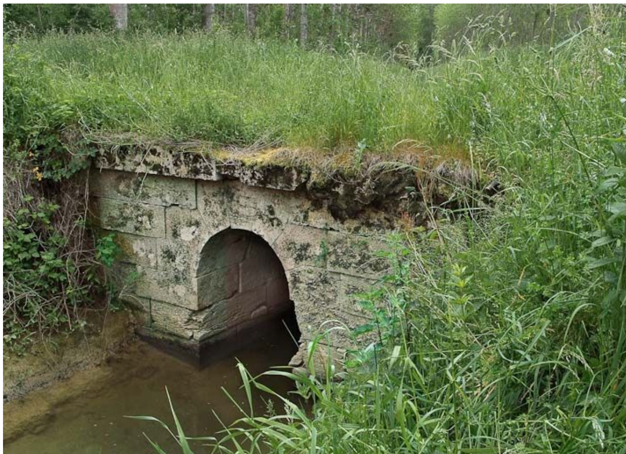
Ponceau, vue rapprochée.
