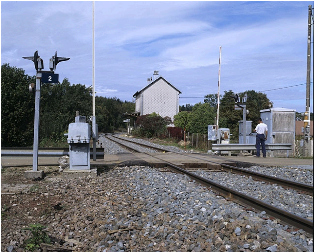
Vue d'ensemble depuis le passage à niveau n° 2, au sud.
