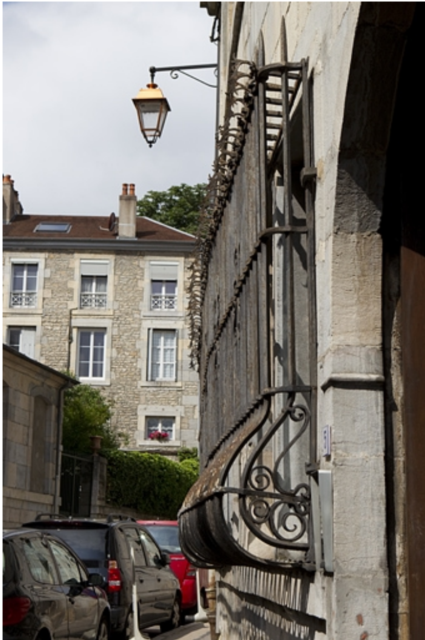
Façade sur rue du logis principal : détail des grilles devant les fenêtres du rez-de-chaussée, de profil.
