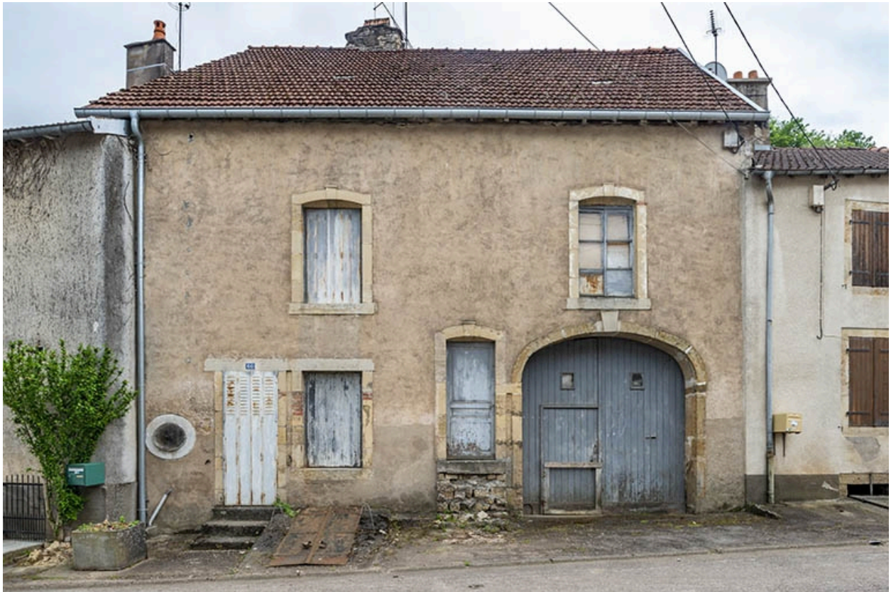
Rue Thiers, maison au n° 60.
