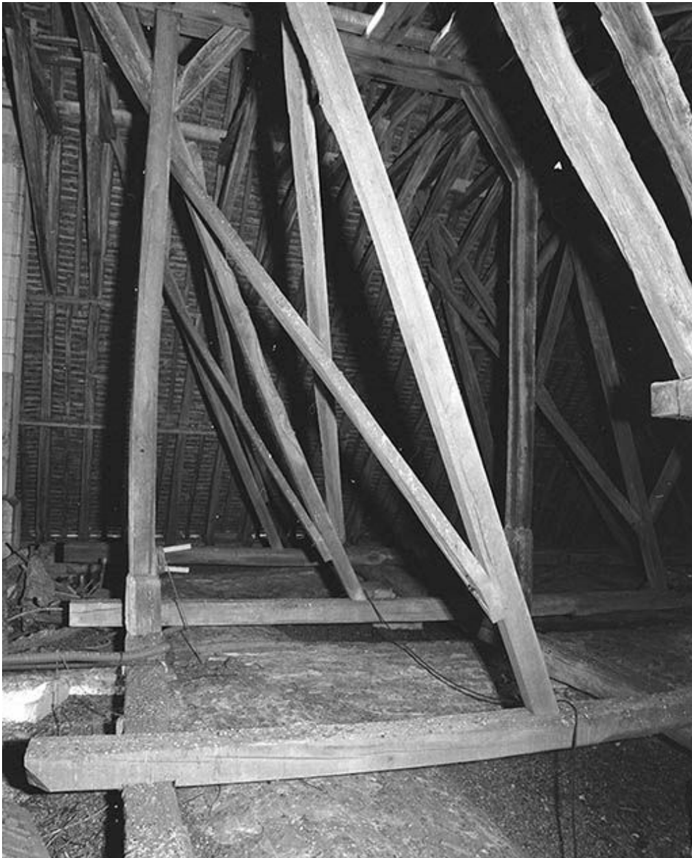
Comble de la nef : partie antérieure de la charpente.
