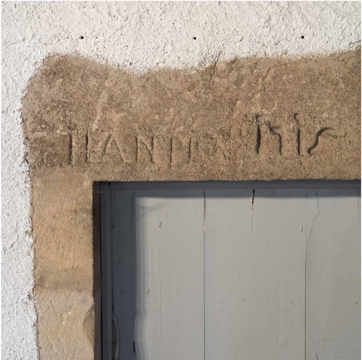
Vue rapprochée d'une inscription et d'une date portée sur un linteau.
