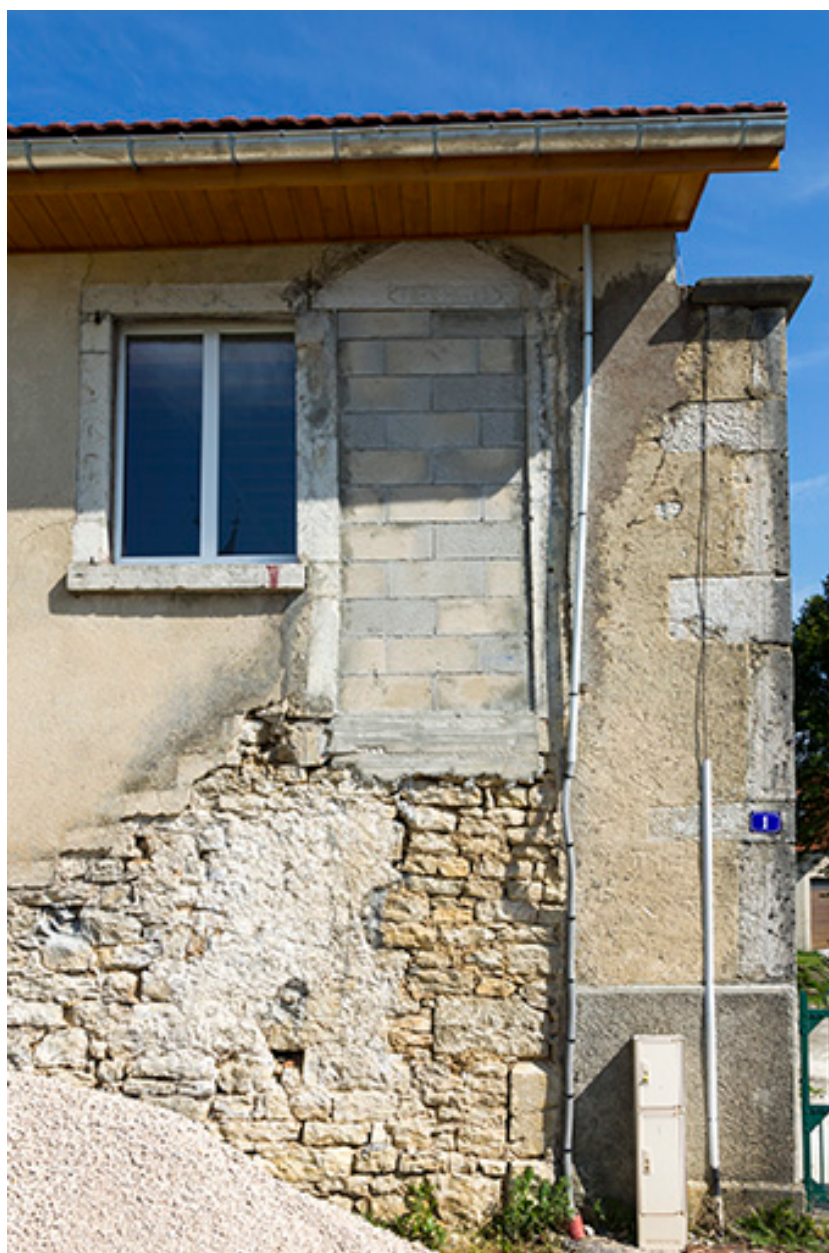
Façade latérale gauche : porte murée à l'étage.
