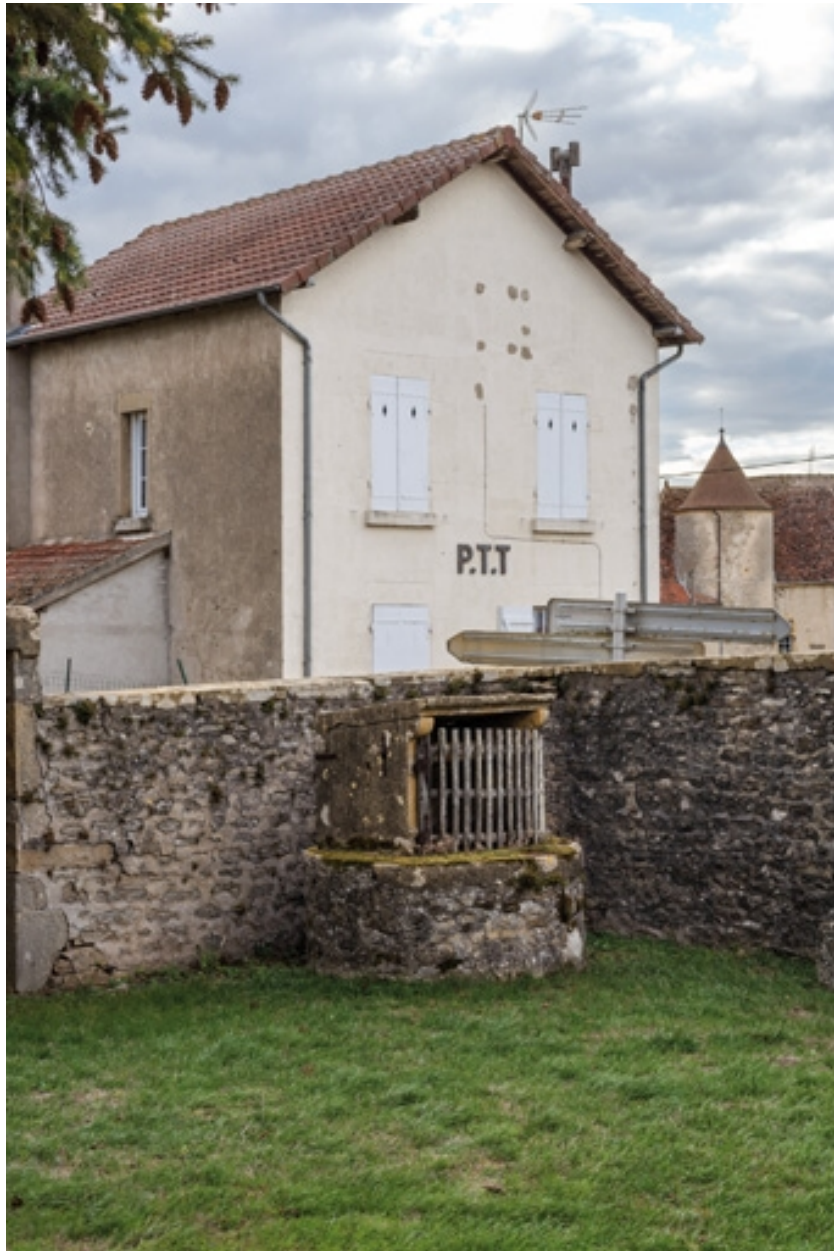
Puits contre le mur de la cour du château
