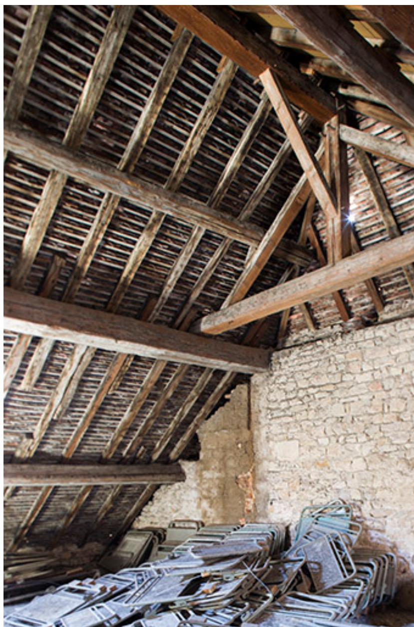
Maison Bonotte : détail de la charpente.
