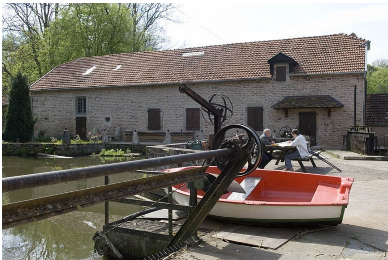
Logement (rive gauche). Façade nord.
