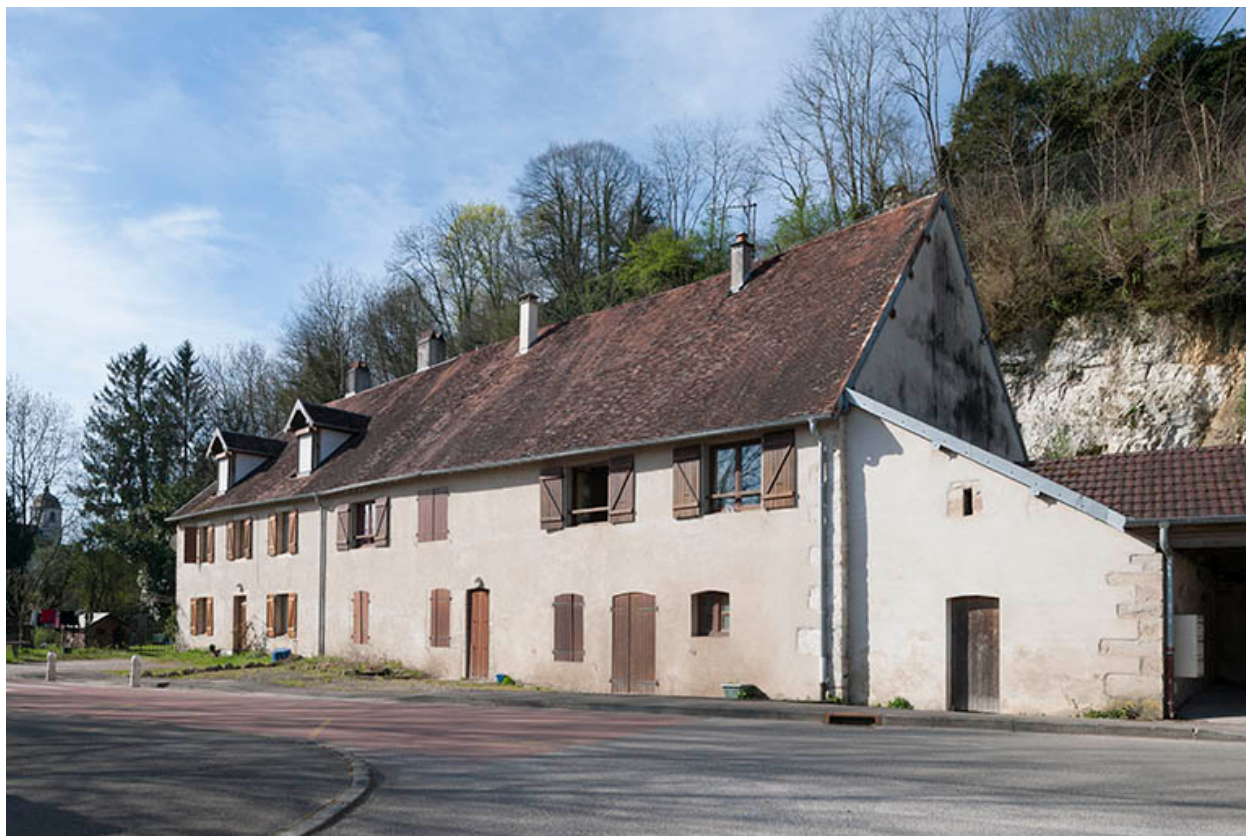
Logement ouvrier (11-13 route d'Emagny).
