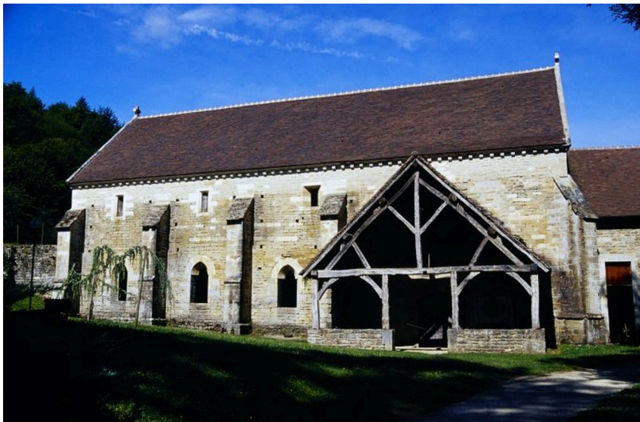
Le cellier, élévation est.
