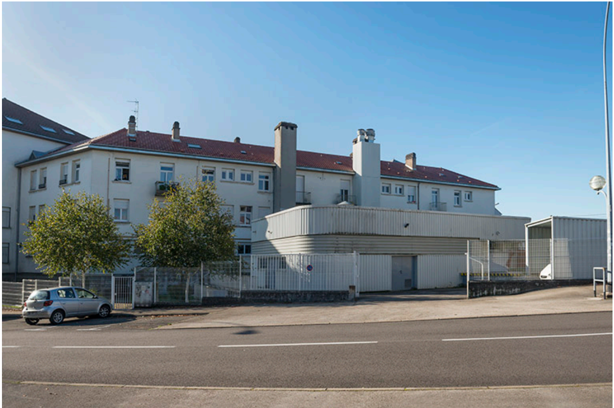
Les façades sur rue de la restauration, au nord de l'avenue du commandant Marceau.
