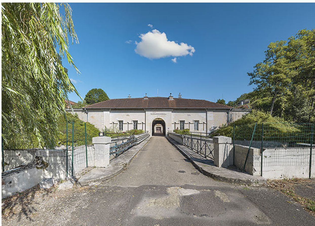
Vue d'ensemble du front de gorge et du pavillon d'entrée.
