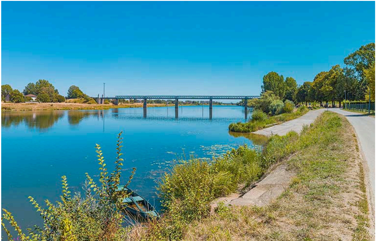
Le pont Boucicaut et le tracé de l'ancien bac, au premier plan.
