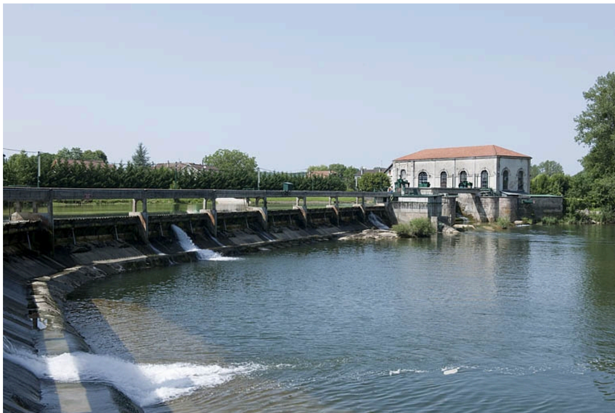
Centrale hydroélectrique de Mathay.
