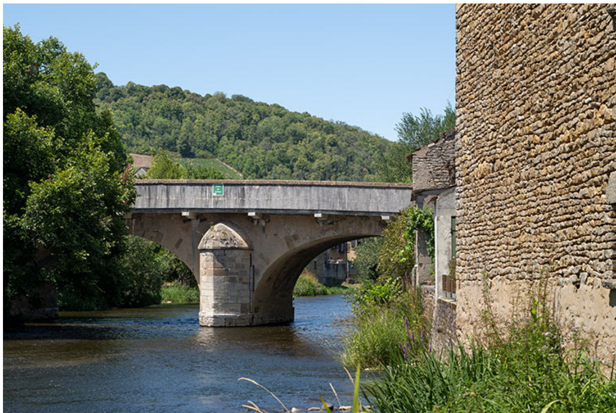
Le pont vu en amont.
