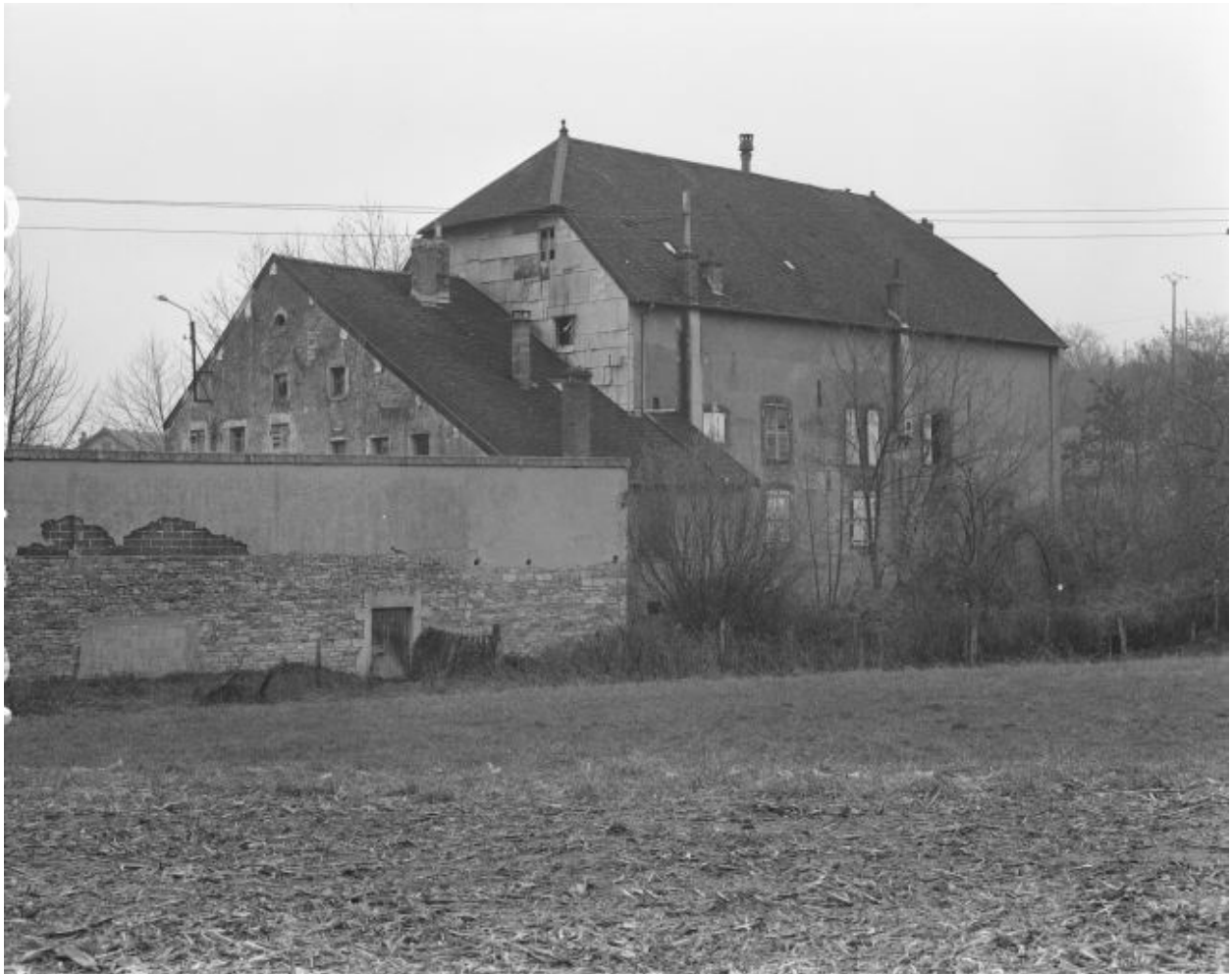
Vue du moulin depuis le sud-ouest.
