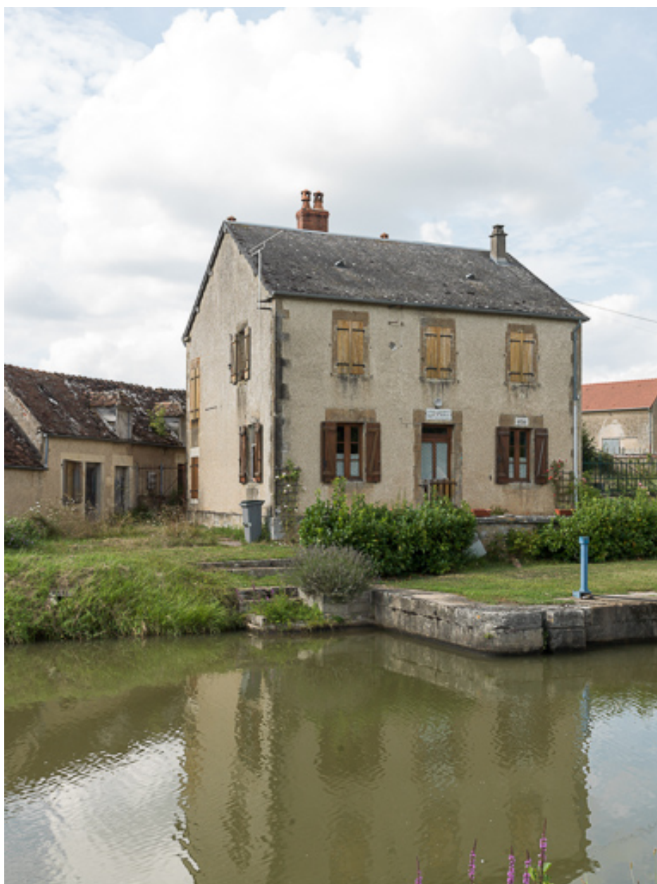
Vue de la maison éclusière.
