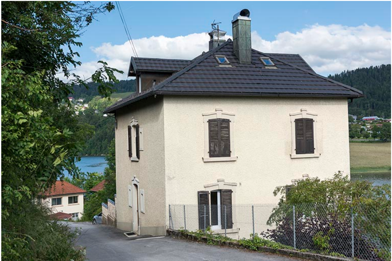
Façades antérieure et latérale droite.
