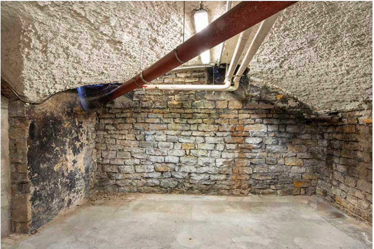
Bâtiment Proudhon : une salle voûtée au sous-sol.
