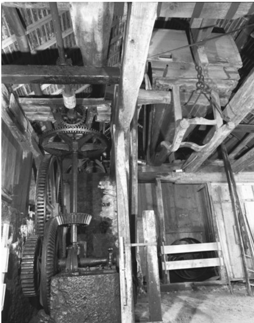
Vue d'un soufflet et du mécanisme.
