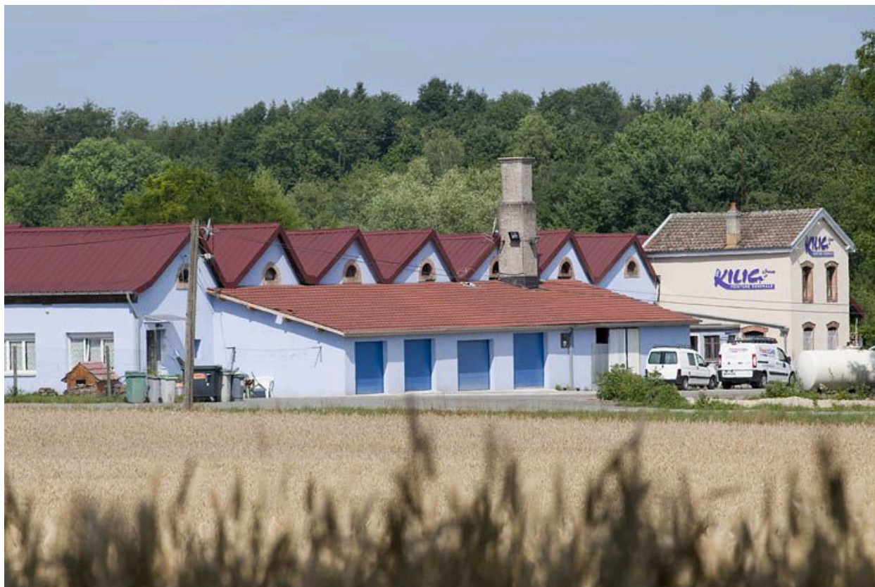
Usine de matériel agricole et d'équipement industriel Japy Frères (usine de la Gare), Dasle.
