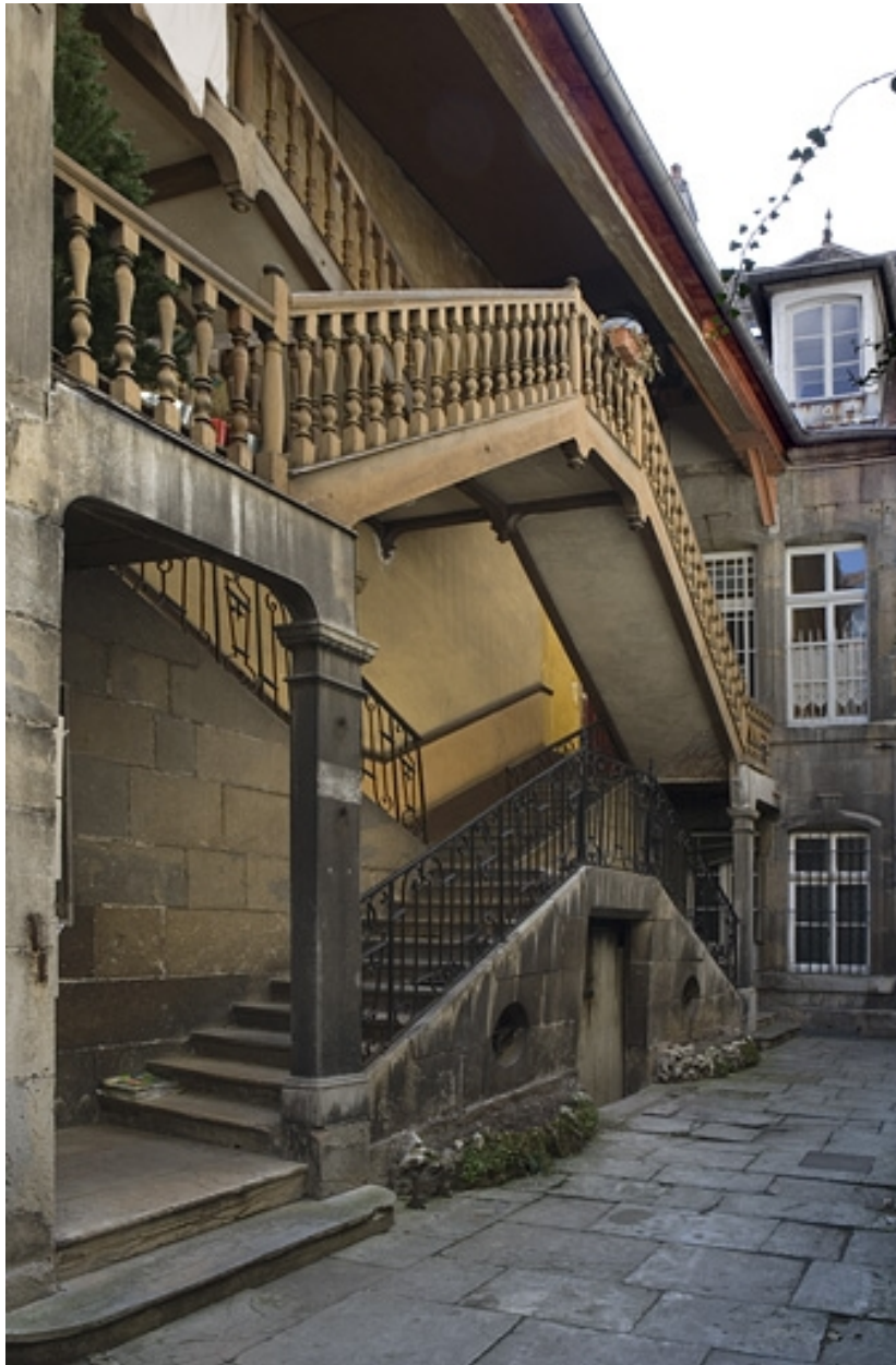
Vue d'ensemble de l'escalier à cage ouverte sur cour, de trois quarts gauche.
