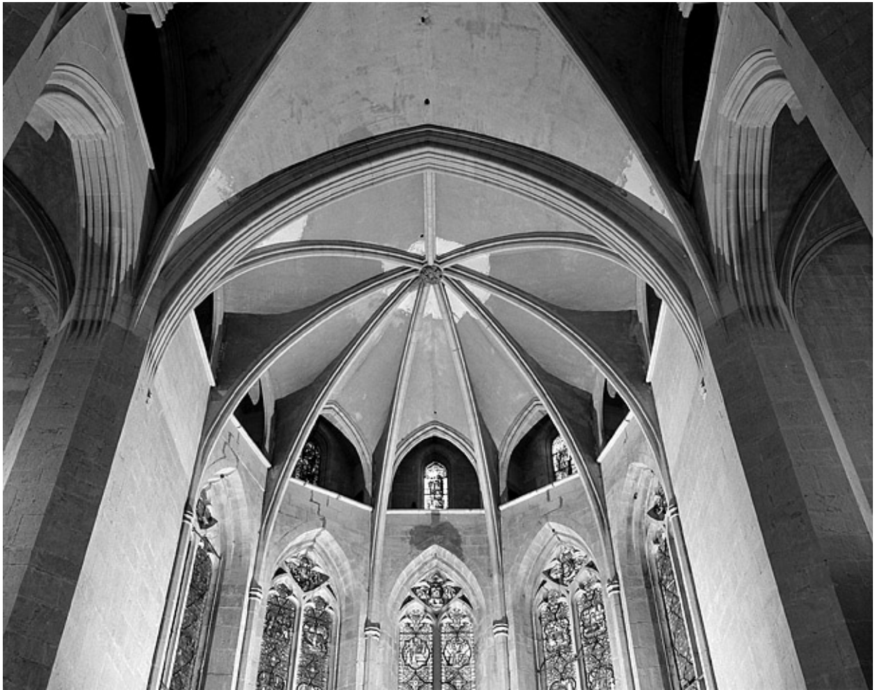
Voûtes de l'abside.
