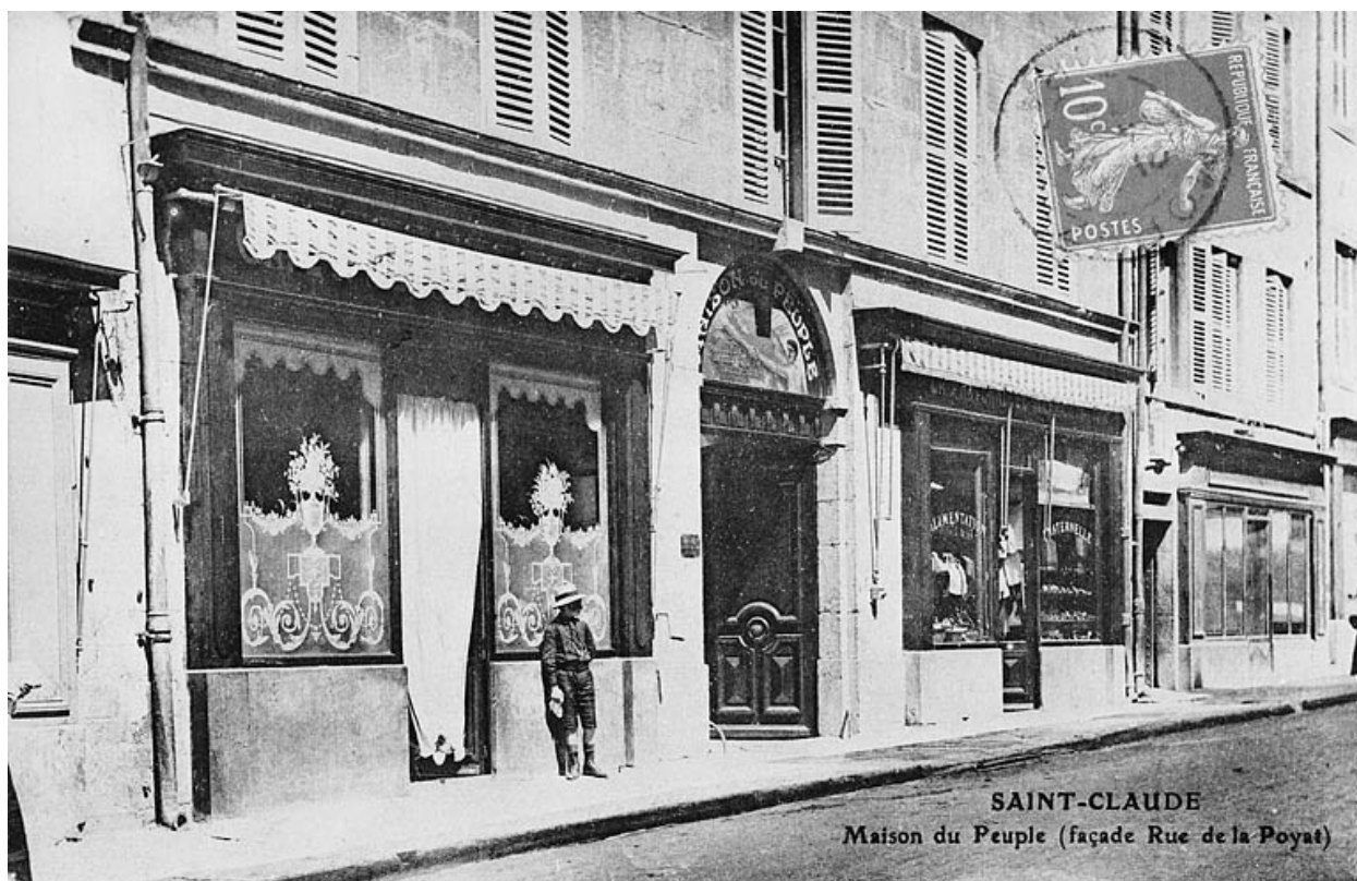
Saint-Claude. Maison du Peuple (façade Rue de la Poyat). Porte la date 12 décembre 1914
