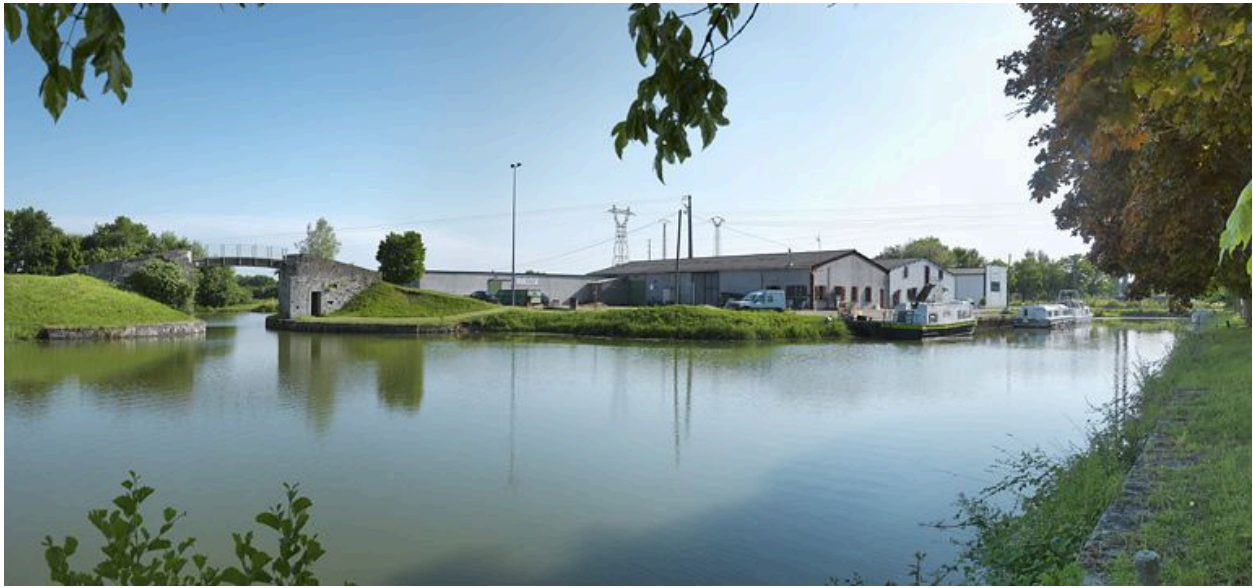
Vue d'ensemble du port de la Copine.
