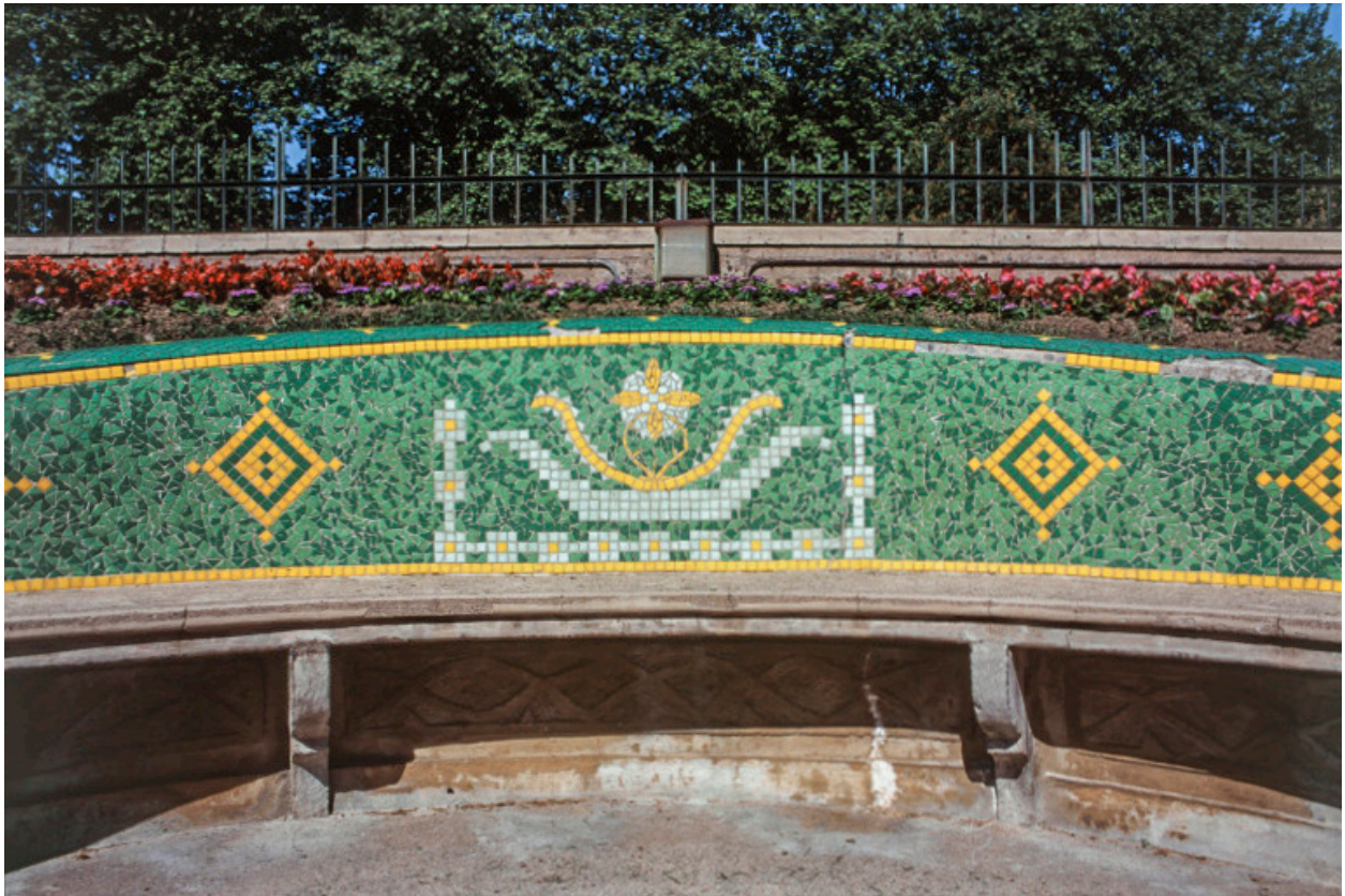
Escalier extérieur devant l'établissement thermal, banc du repos central, détail.
