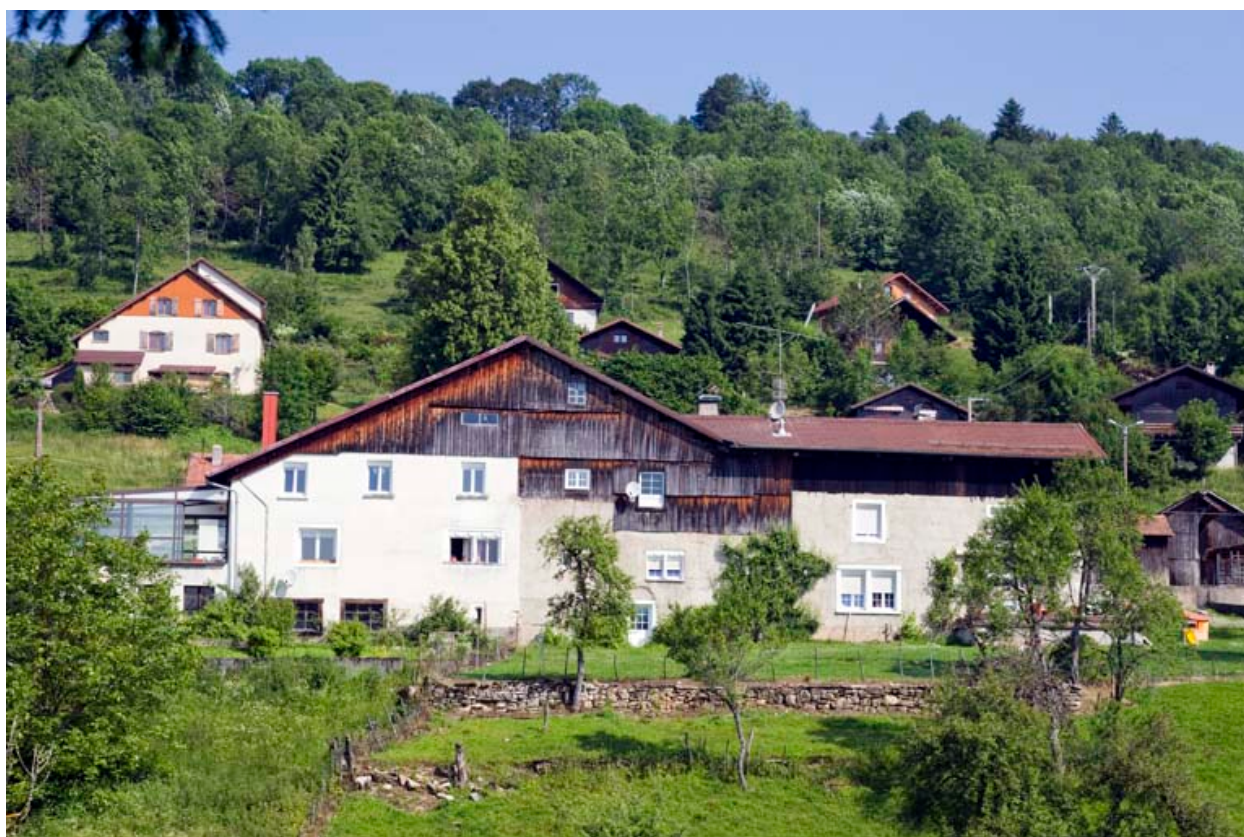
Façade latérale droite.
