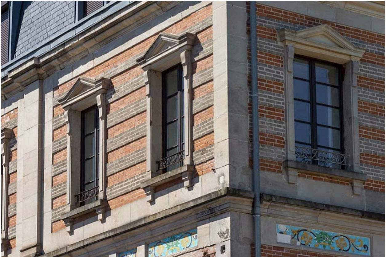
Façade sur la rue de Grammont, baies du troisième niveau.
