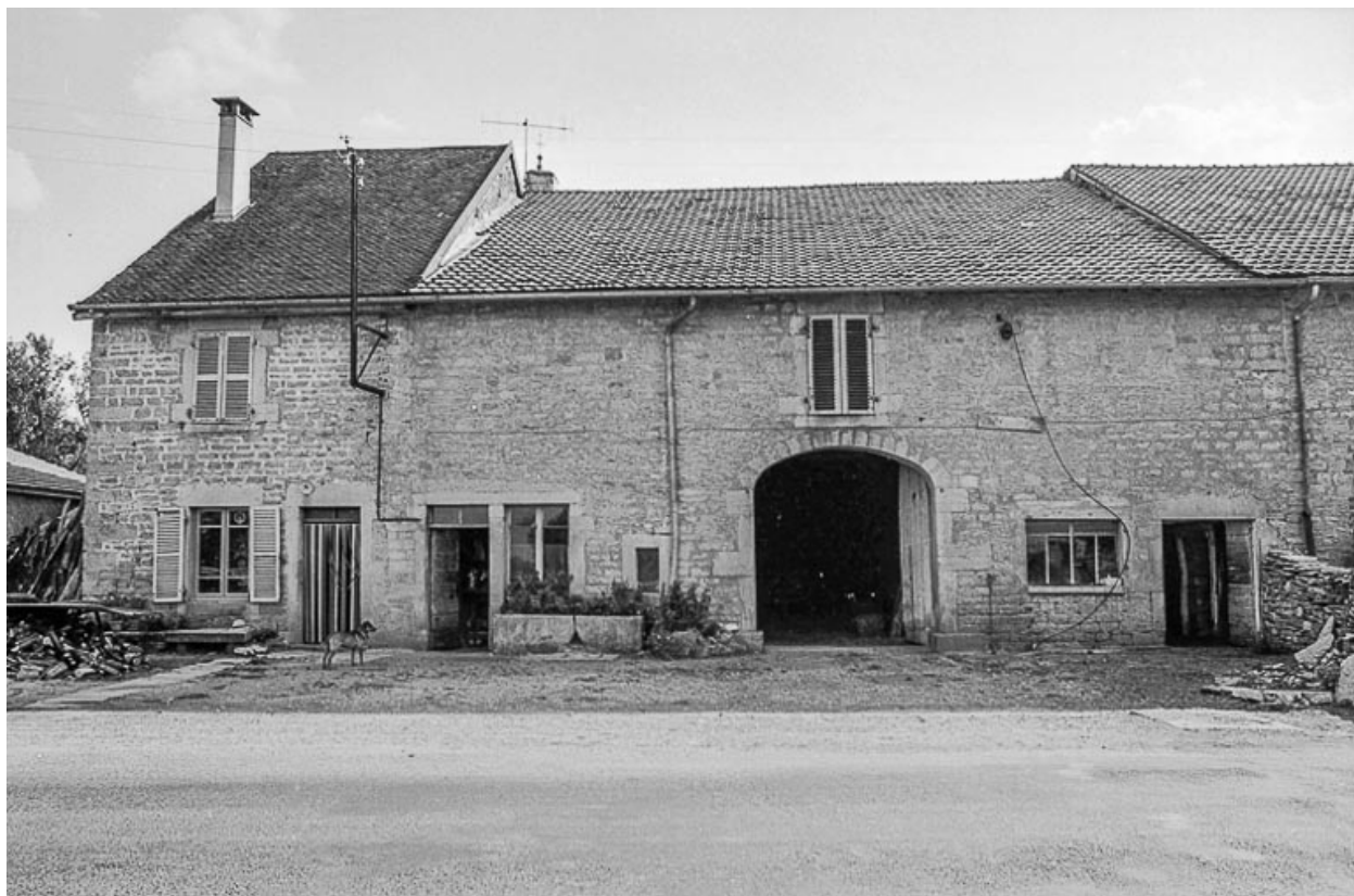
Ferme cadastrée A3 195 : façade antérieure.
