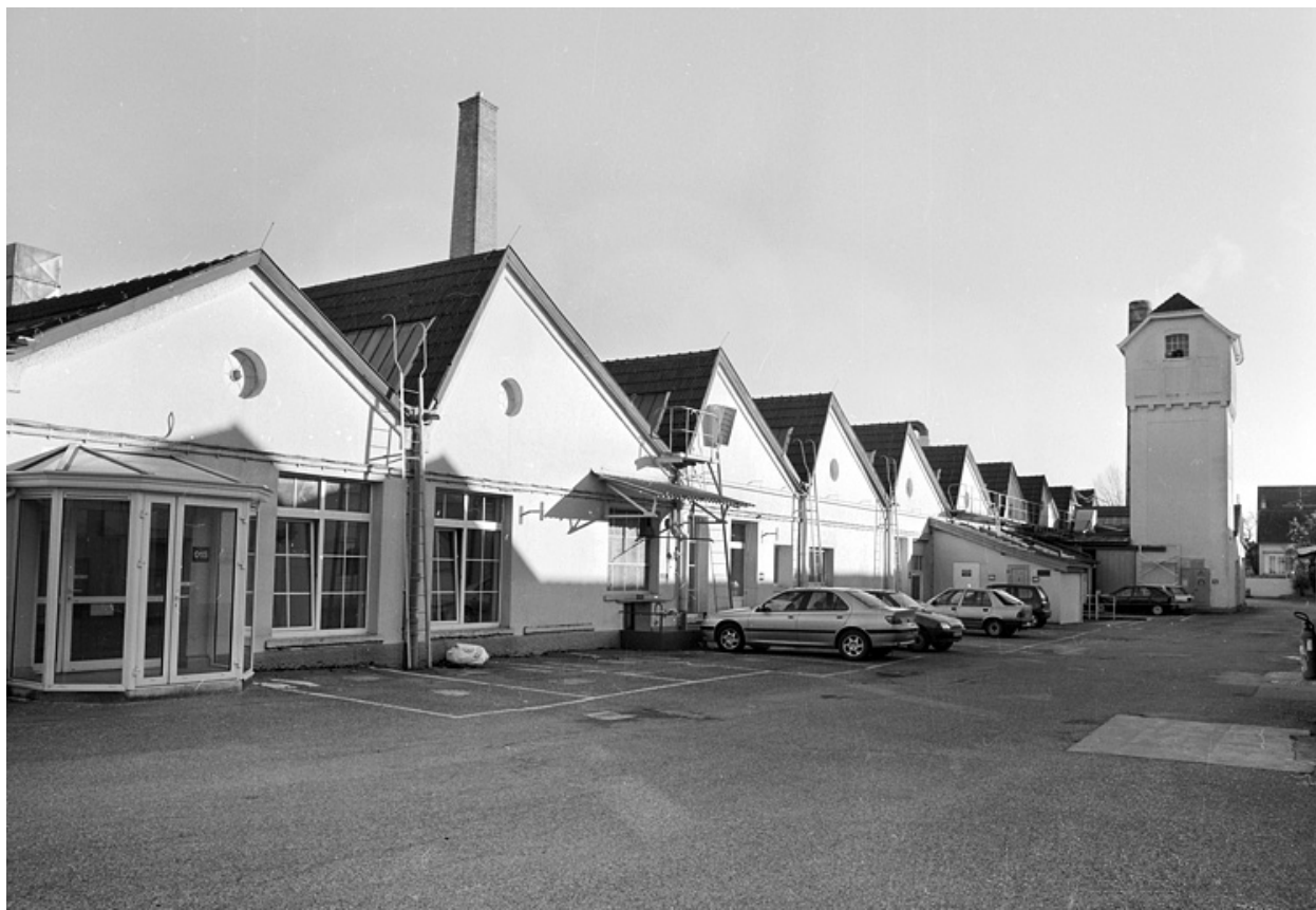
Pignons ouest de l'atelier de fabrication.
