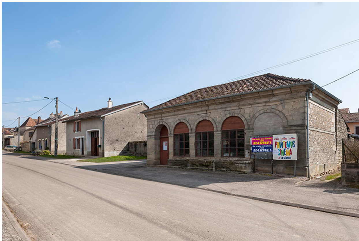
Ancien lavoir, rue Antoine Lumière.
