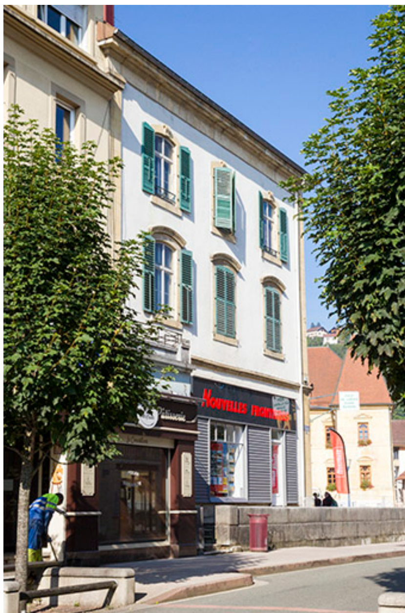
Façade latérale gauche, de trois quarts gauche.
