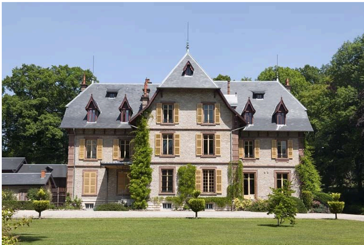
Vue rapprochée de la façade antérieure.
