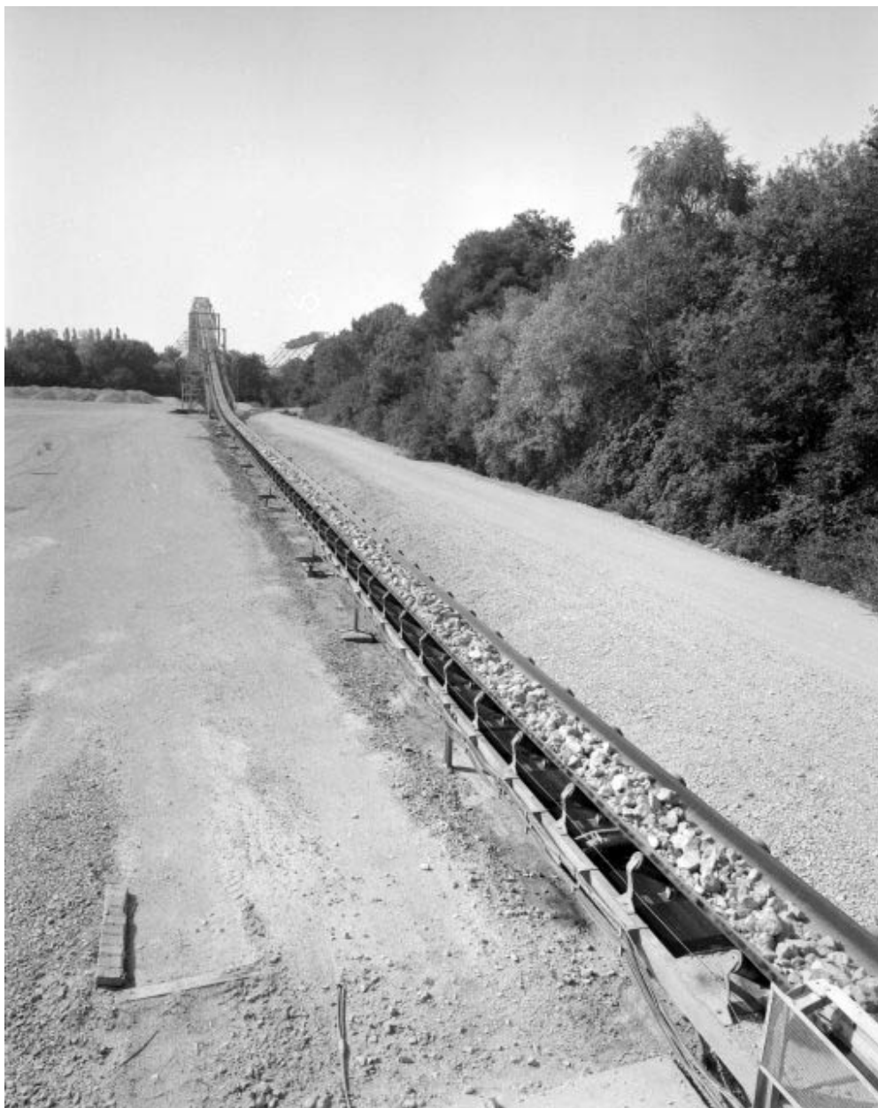
Transporteur automatique à bande et portique sur le canal, vus depuis l'installation de renvoi (vue rapprochée).
