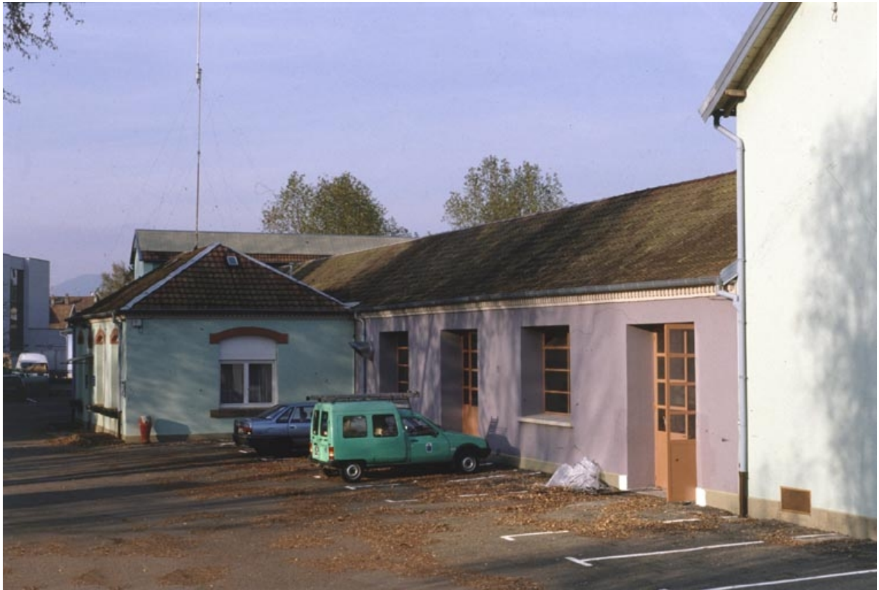
Bureaux et façade de l'atelier du tissage.
