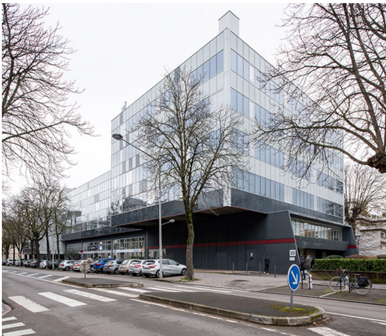
Façade nord-ouest et façade sud-ouest.
