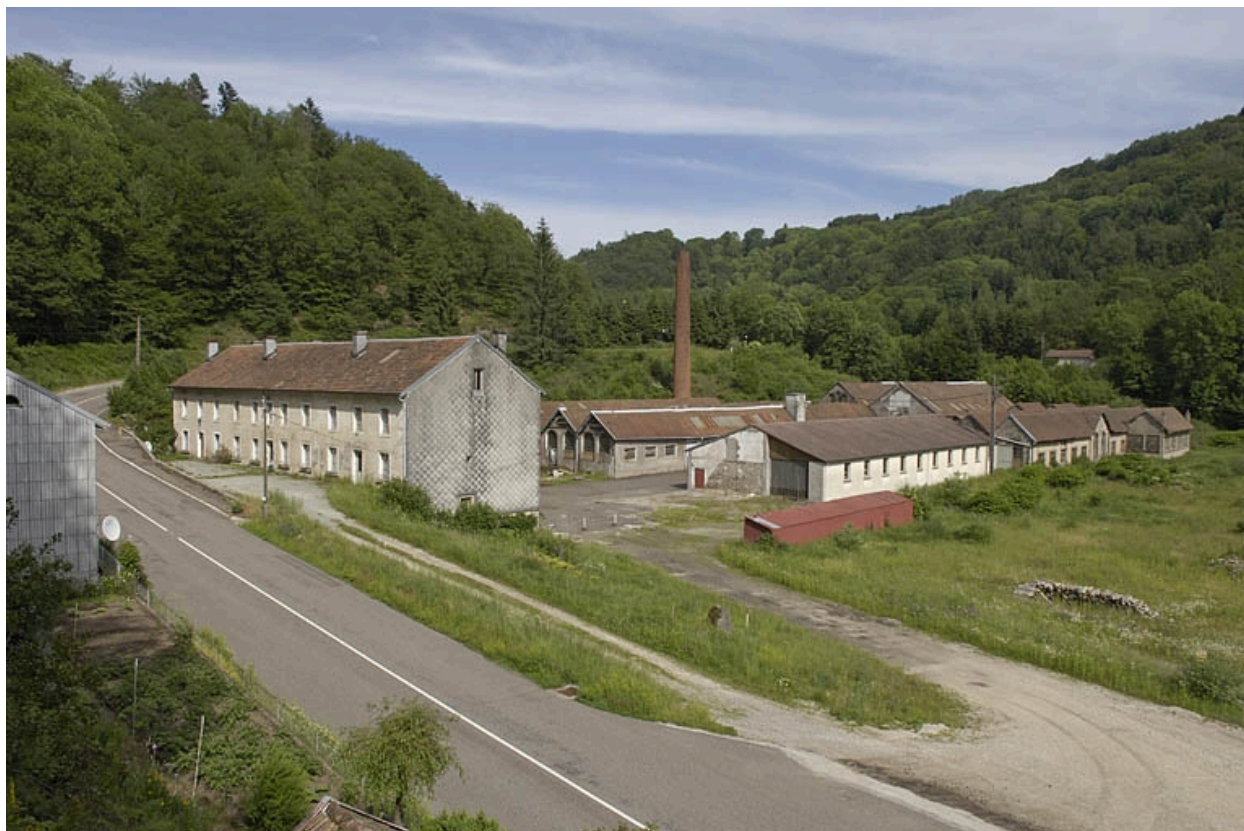
Usine de transformation des métaux dite forge Clément, Corravillers.
