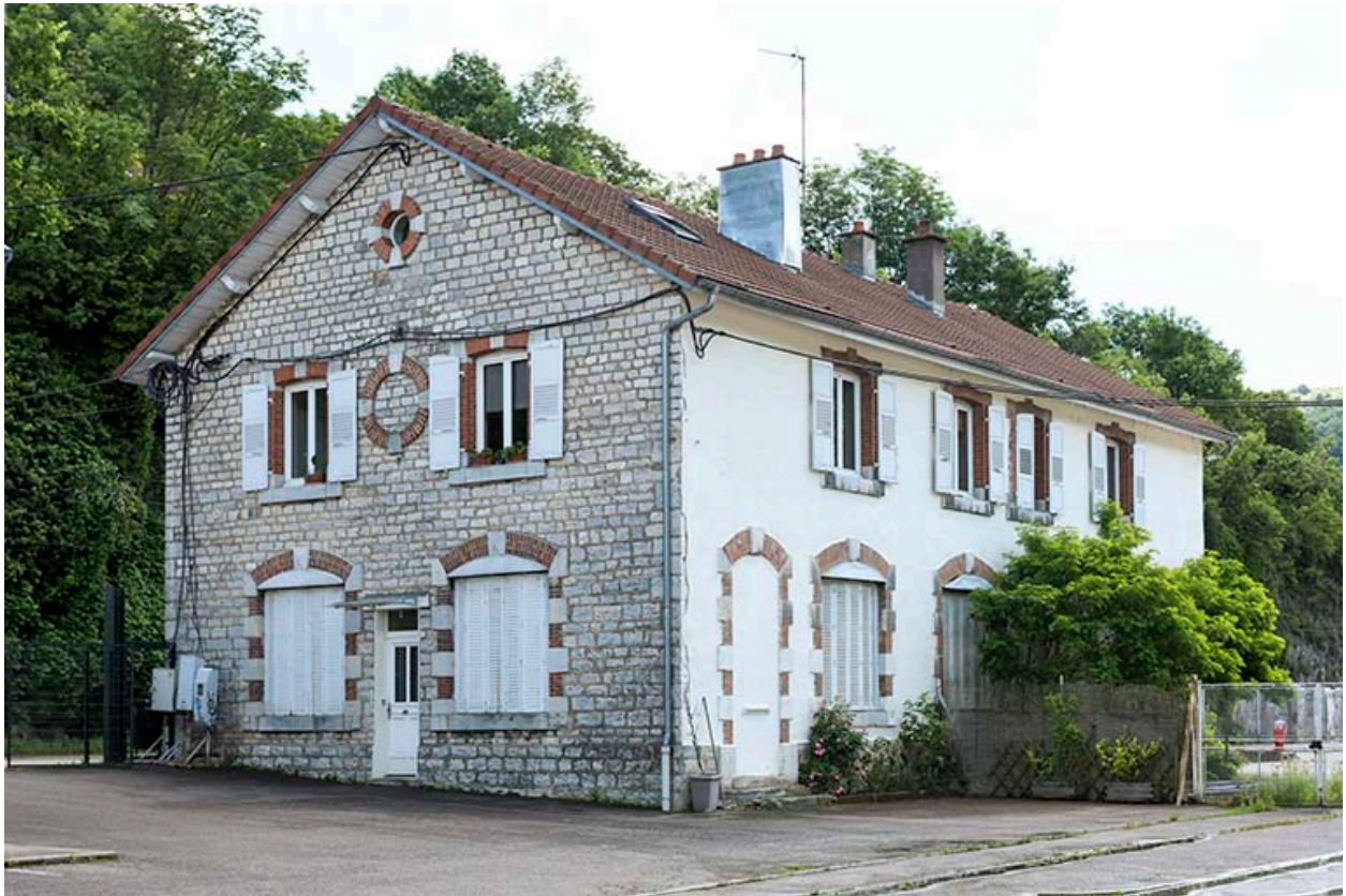
Etat en 2016. Usine B : logement, depuis la cour à l'ouest.
