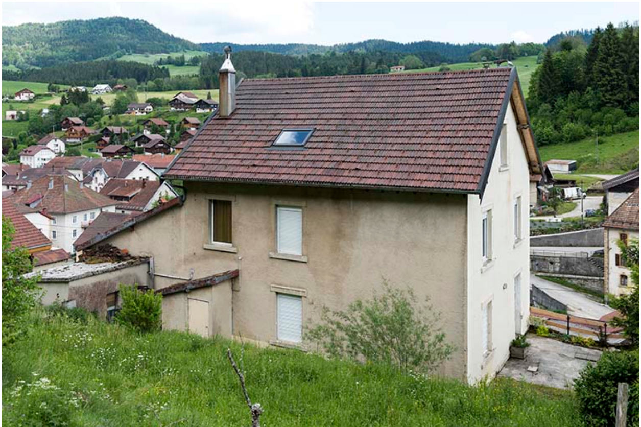
Façades postérieure et latérale gauche.
