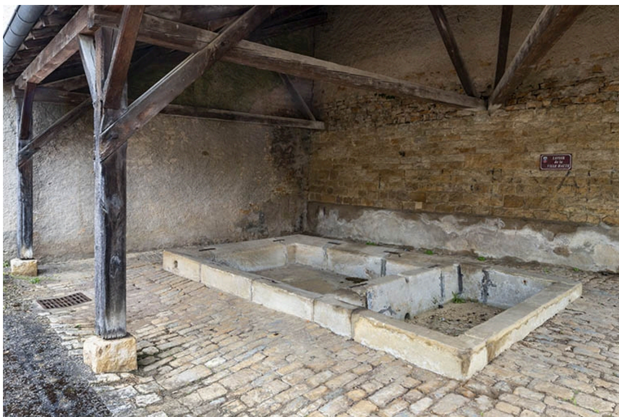
L'intérieur du lavoir.
