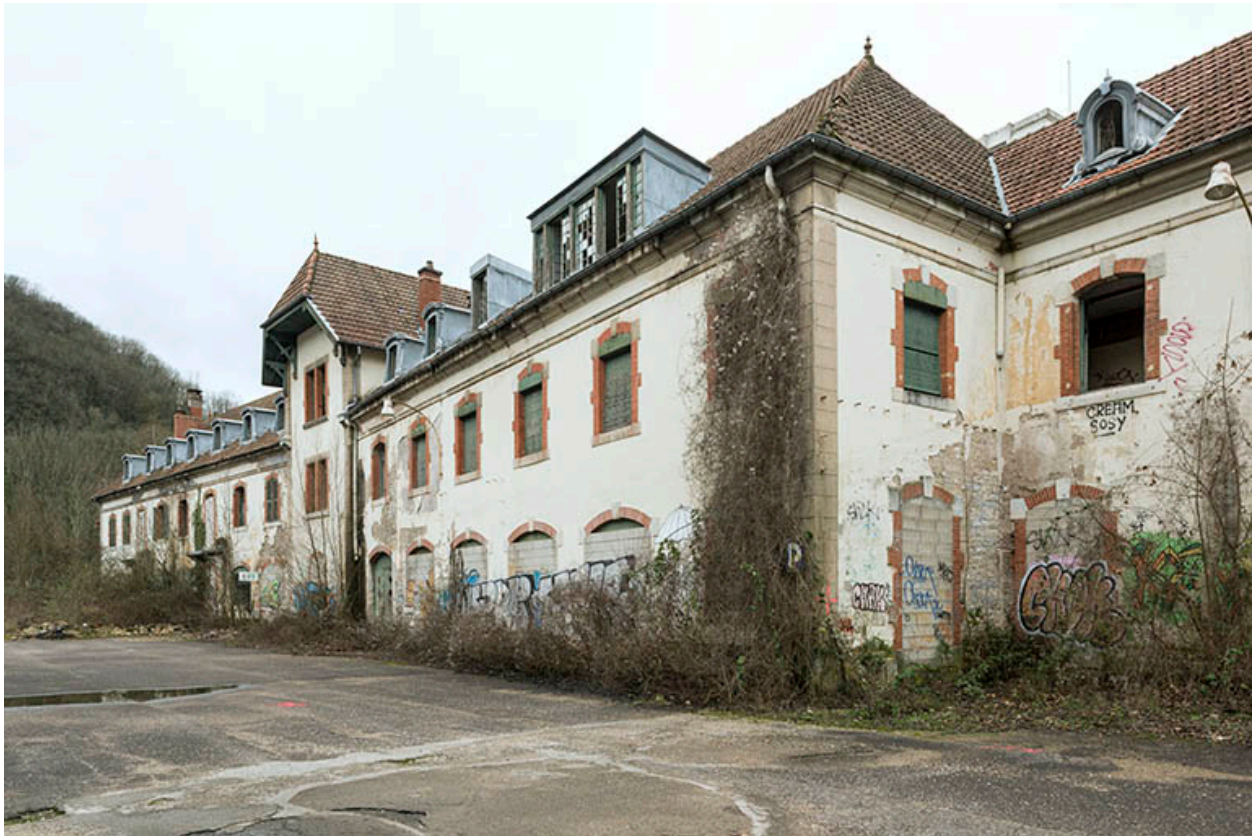
Etat en 2016. Usine A : façade sur cour de l'extrémité occidentale des bureaux.
