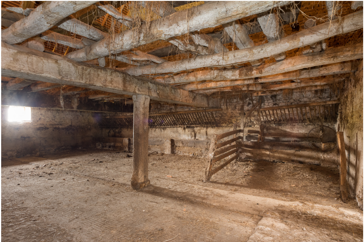
Vue de l'étable double, à gauche de la remise
