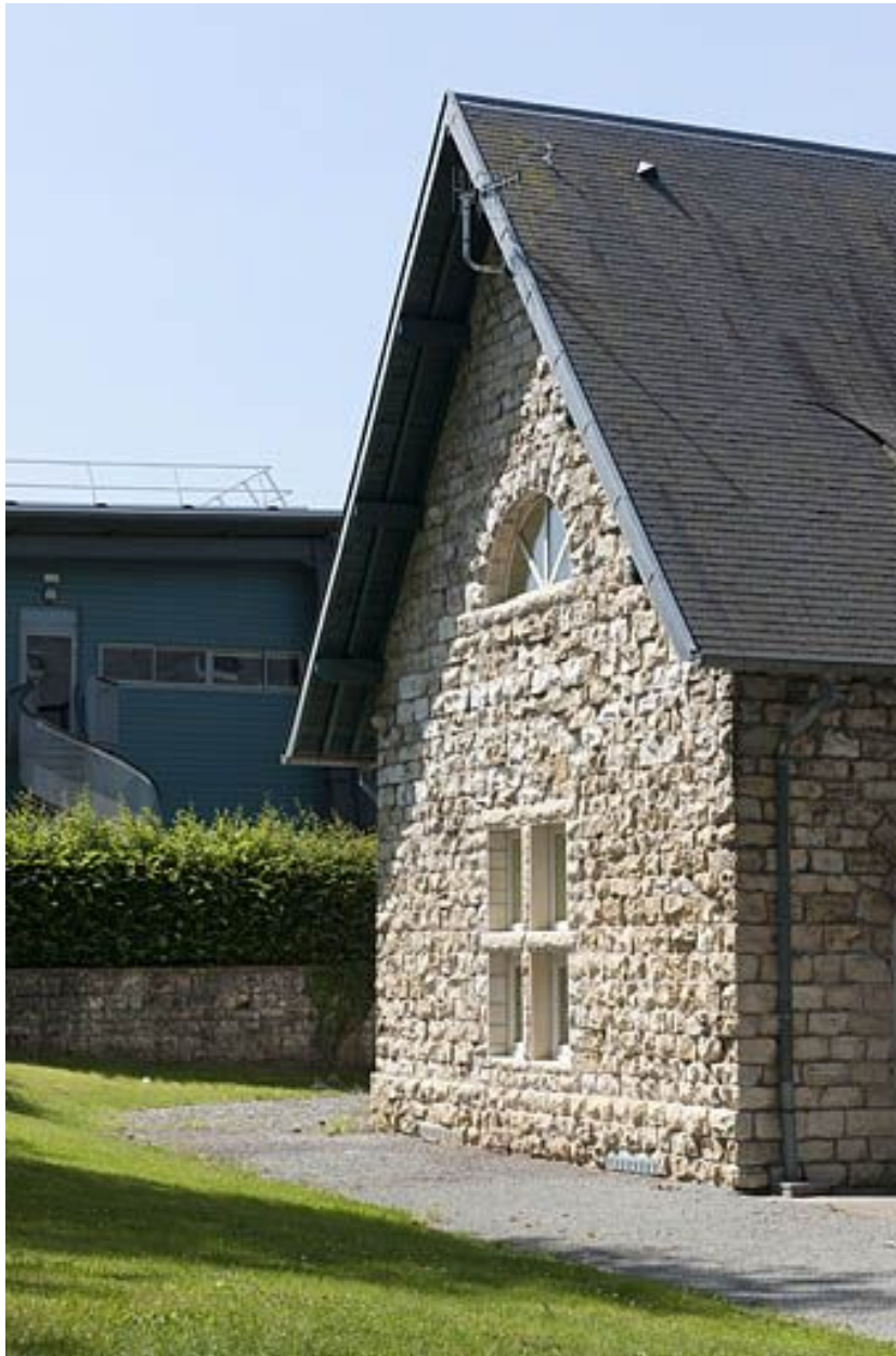
Conciergerie. Pignon sud de la façade postérieure.
