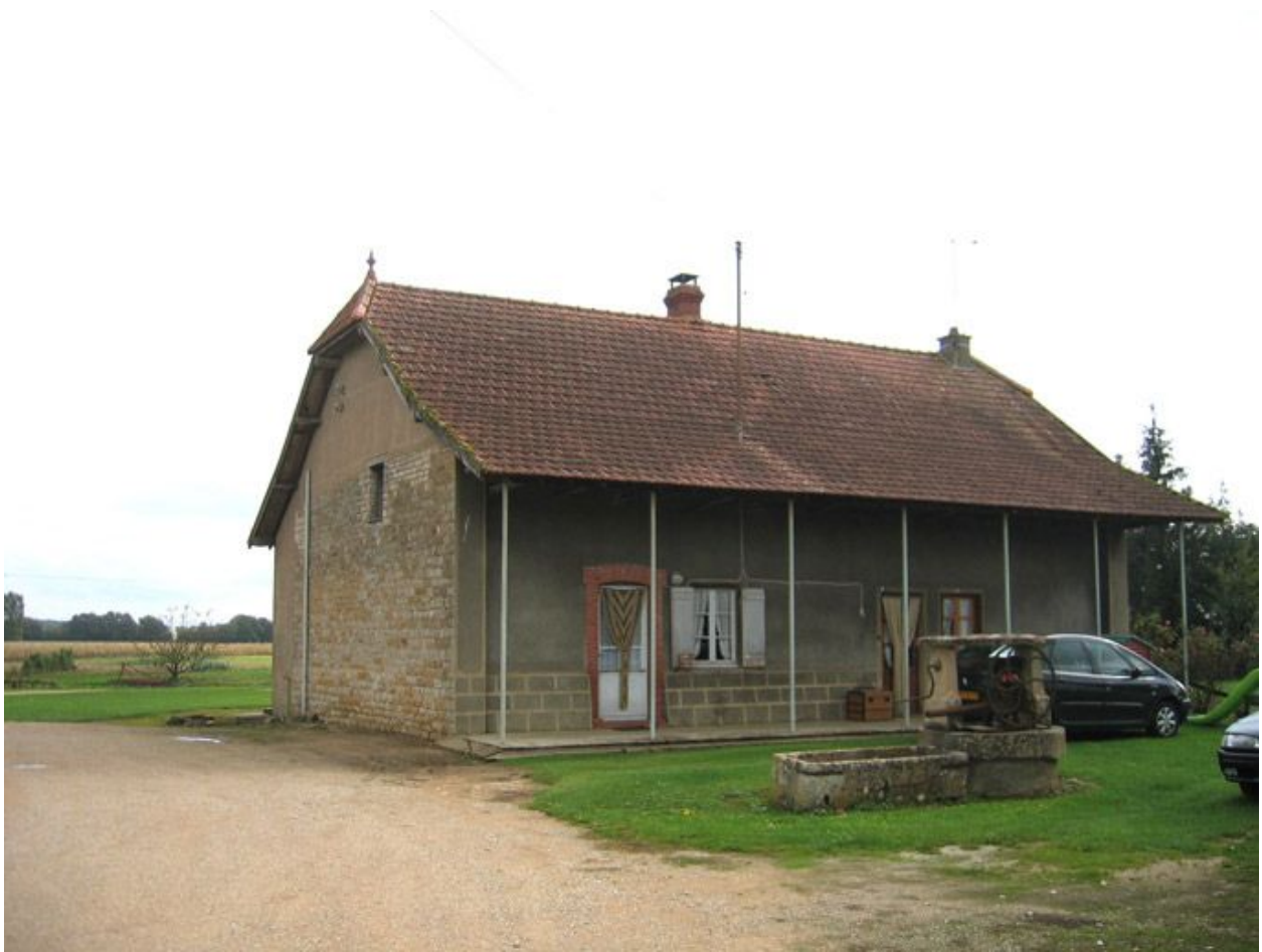
Vue d'ensemble de la façade de l'habitation.
